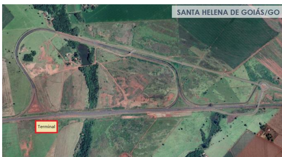
Figura 1 - Imagem aérea do Pátio de Santa Helena de Goiás/GO
