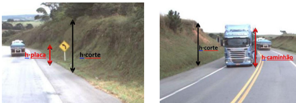
Figura 8 – Exemplos de obtenção da altura de corte. Fonte – Adaptado do EVTEA (J. MALUCHELI; CONGRESOLO, 2016).
