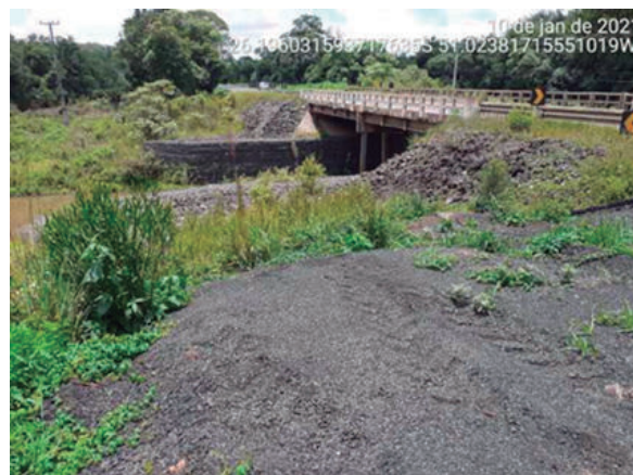
Trecho da APP utilizada como área de depósito de material.
