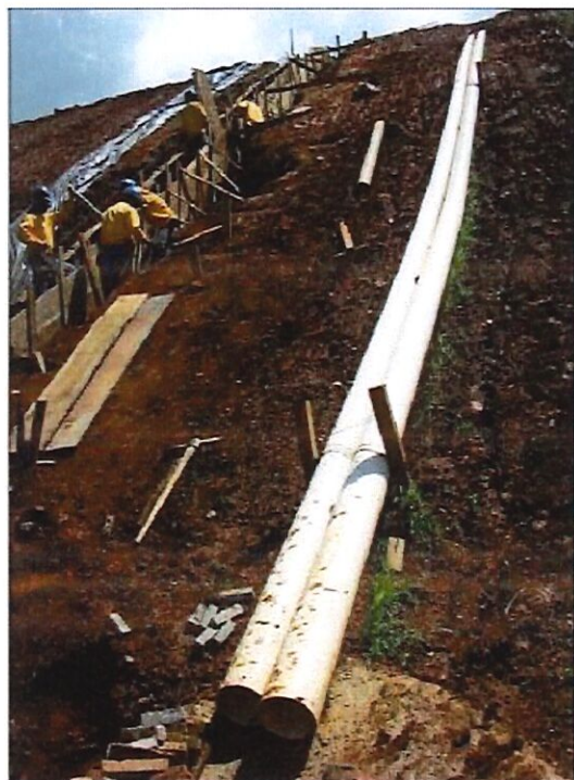
Figura 16. Entrada e descida d'água provisórias - proteção de talude de aterro (FNS,GO)
