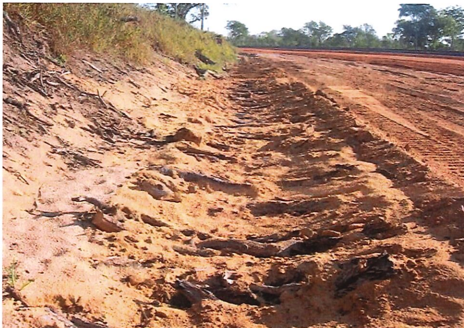
Fig. 51. Material lenhoso picotado, incorporado no solo e servindo de dissipador de energia
