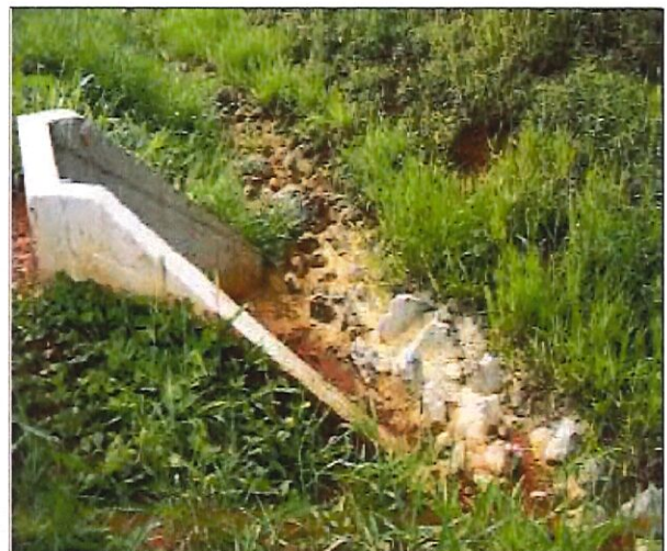
Figuras 24 e 25 . Descida d'água em degraus e saída de bueiro com dissipador de energia (FNS TO e GO).
