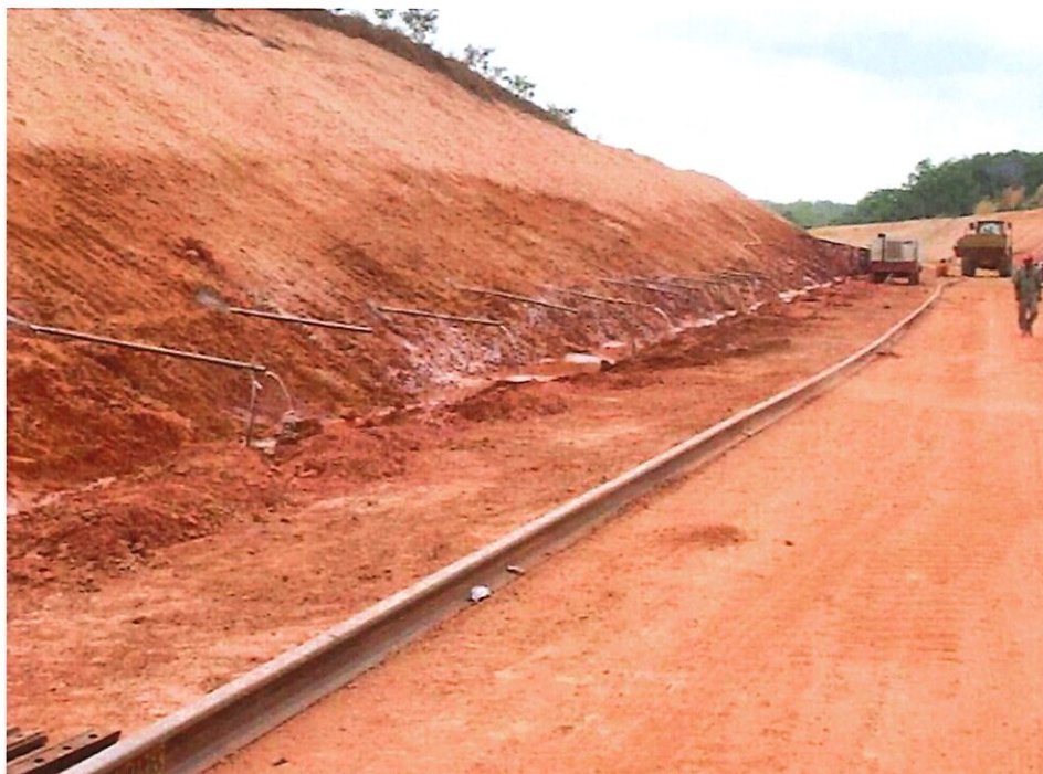
Fig. 45. Vista dos drenos sub-horizontais (DHPs) instalados em um talude da Ferrovia
