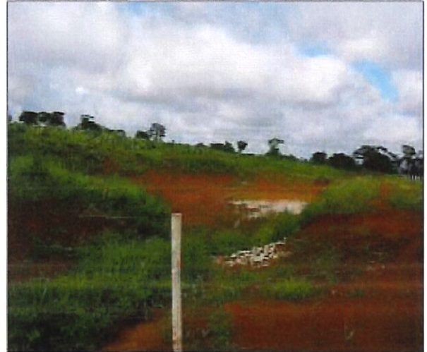
Figura 23. Bacias de acumulação e contenção com bordas protegidas por capim umidícula (FNS, GO).
