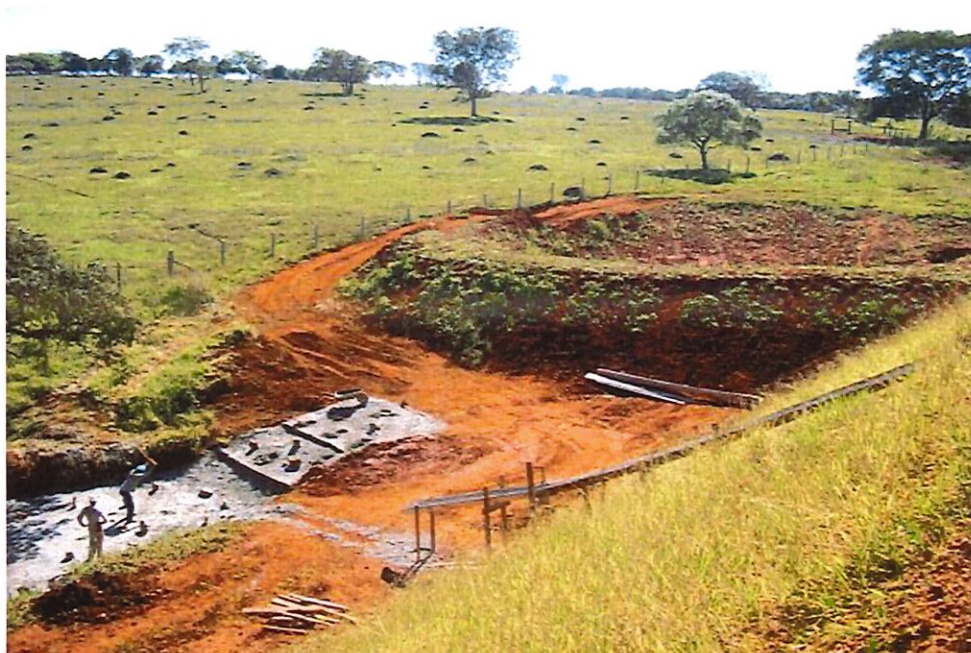
Figura 28. Aspecto geral – Construção de bacia de contenção em área de empréstimo, com bordas vegetadas. Logo abaixo construção de dissipador de energia.
