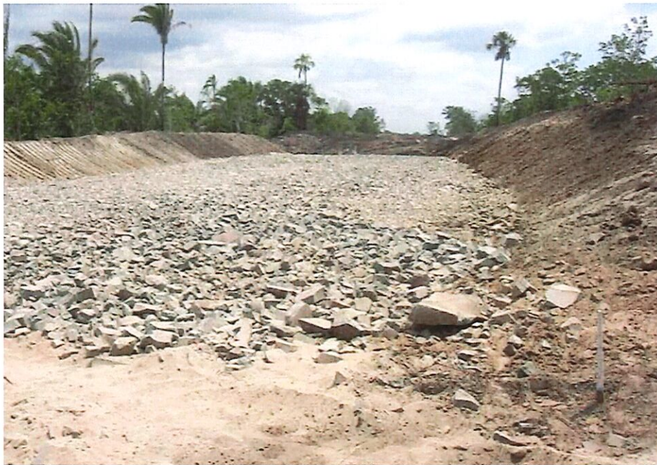
Fig. 44. Detalhe da camada de areia na base do colchão drenante, funcionando como camada filtrante
