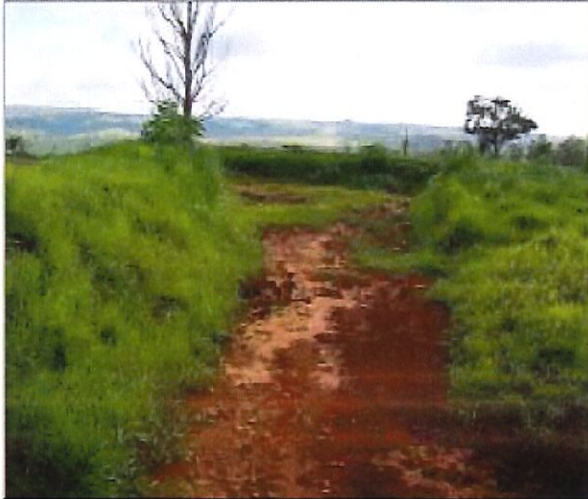
Figura 23. Bacias de acumulação e contenção com bordas protegidas por capim umidícula (FNS, GO).
