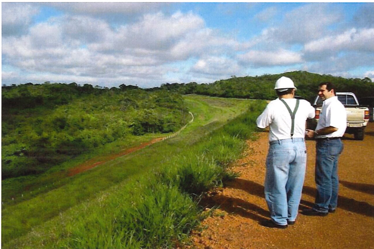
Figura 21. Taludes de aterro protegidos com braquiária – aspecto inicial da vegetação dos taludes (FNS, GO).
