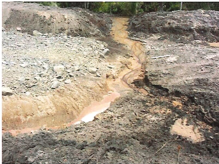
Fig. 42. Detalhe da camada de rachão no corte e vala para drenagem da água do subleito
