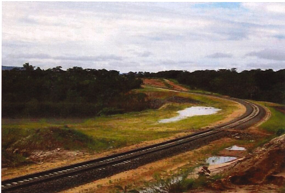
Fig. 49. Vista mostrando bacias de infiltração em funcionamento
