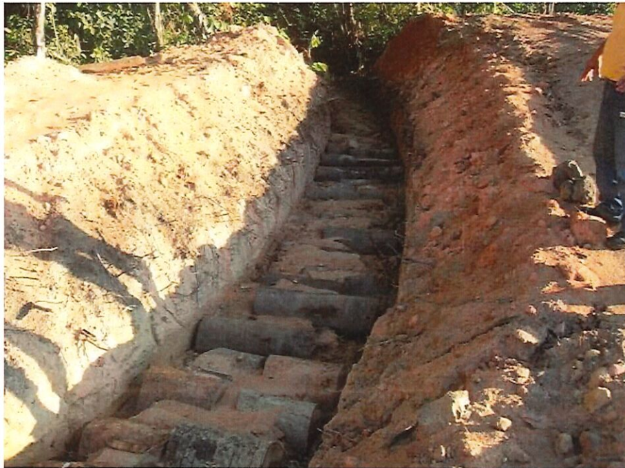
Fig. 50. Foto mostrando a alternativa de dissipador de energia em valeta empregando troncos fracionados oriundos do desmatamento
