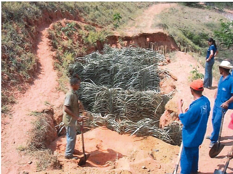
Figura 35. Controle de erosão através do emprego de diques.
