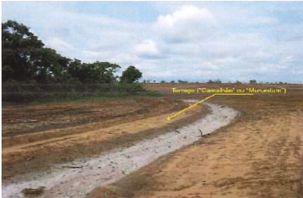
Figura 26. Terraços ou murunduns construídos como dispositivos de contenções de processos erosivos pluviais.
