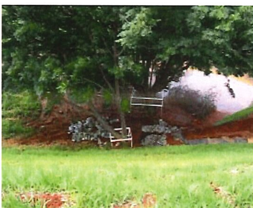
Figura 17. Bacia de acumulação e infiltração e valeta com dissipador de energia (FNS,GO)
