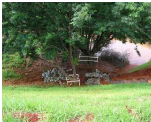
Figura 16. Entrada e descida d'água provisórias - proteção de talude de aterro (FNS,GO)
