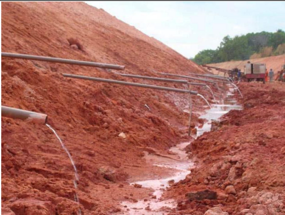
Fig. 47. Vista dos drenos em funcionamento e do equipamento de perfuração
