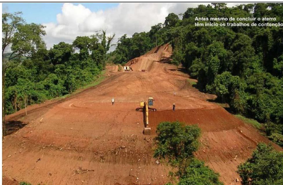
Figura 20. Fase 3 – Escarificação do talude de aterro para melhor fixação da proteção vegetal
