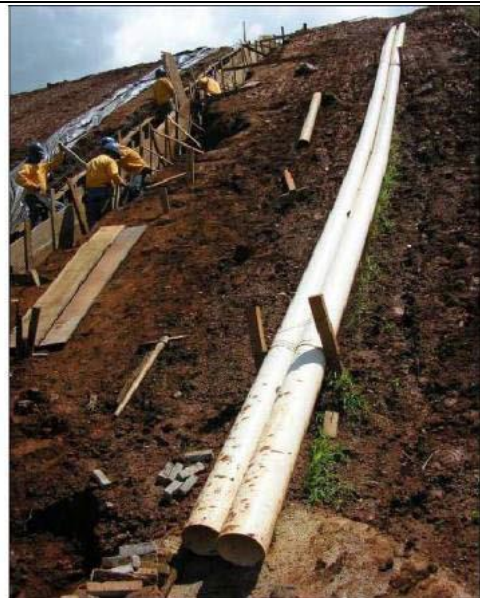
Figura 16. Entrada e descida d'água provisórias - proteção de talude de aterro (FNS,GO)
