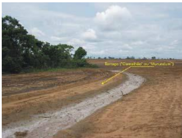
Figura 26. Terraços ou murunduns construídos como dispositivos de contenções de processos erosivos pluviais.
