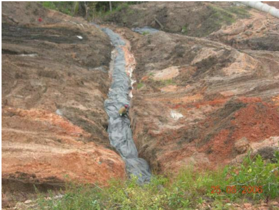
Fig. 48. Execução de dreno subterrâneo (charuto), com objetivo de proteção de nascente e manutenção do corpo hídrico.
