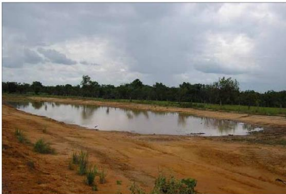
Figura 33. Empréstimos laterais tendo como finalidade bacias de acumulação e infiltração
