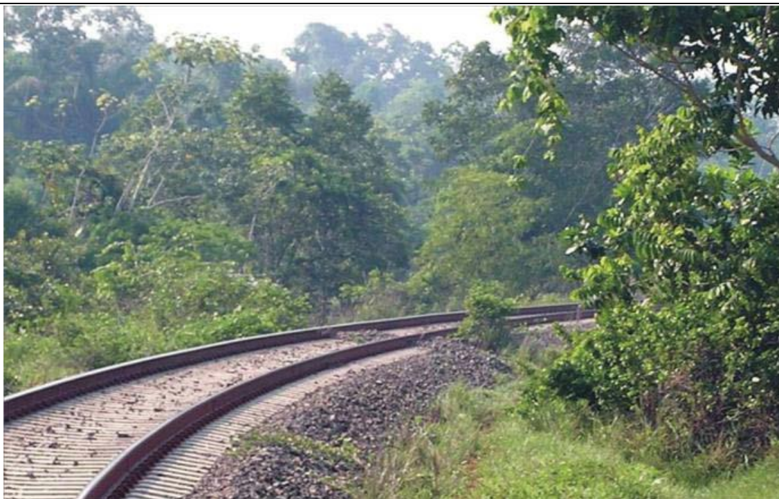
Figura 22. Taludes de aterro protegidos com a regeneração da vegetação nativa – aspecto final (FNS, MA).
