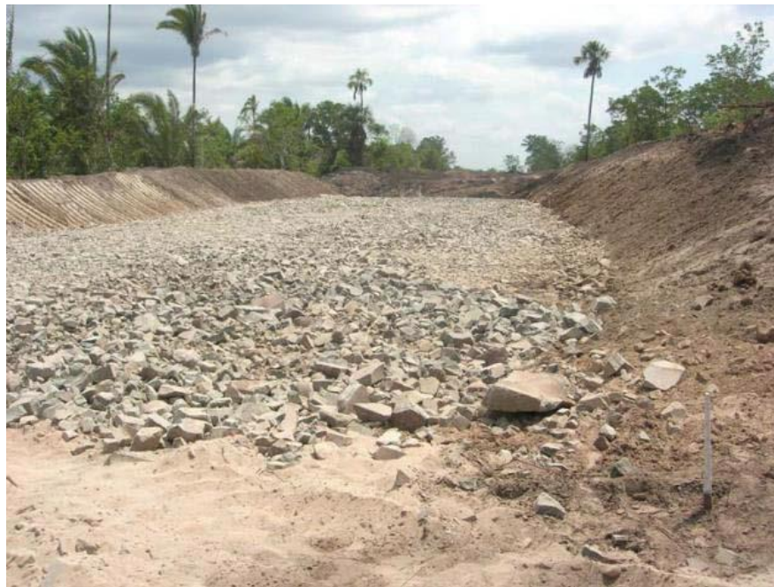
Fig. 44. Detalhe da camada de areia na base do colchão drenante, funcionando como camada filtrante
