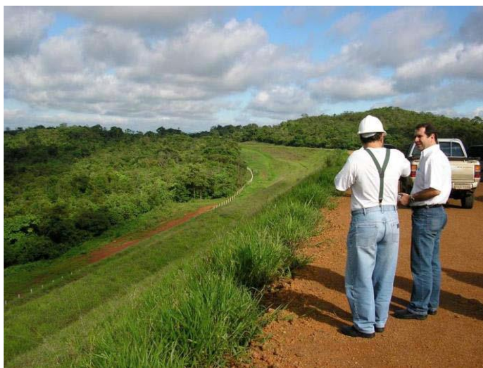
Figura 21. Taludes de aterro protegidos com braquiária – aspecto inicial da vegetação dos taludes (FNS, GO).
