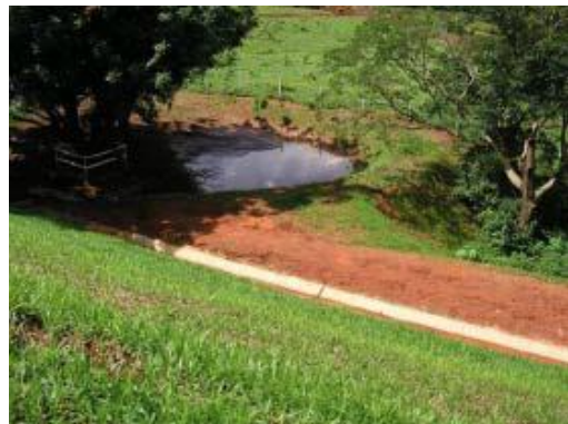
Figura 16. Entrada e descida d'água provisórias - proteção de talude de aterro (FNS,GO)
