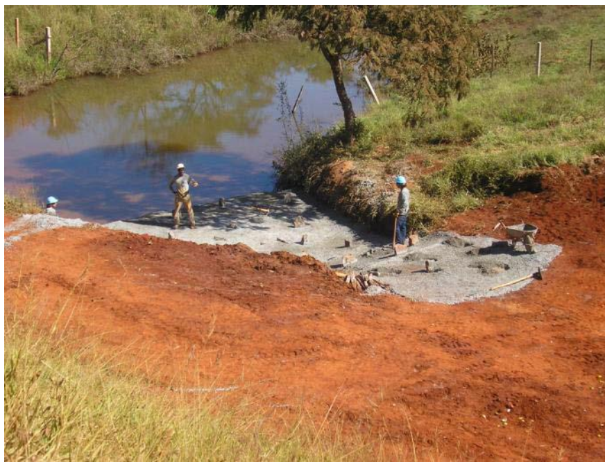
Figura 29. Aspecto geral – Construção de bacia de dissipador de energia logo abaixo da bacia de contenção.
