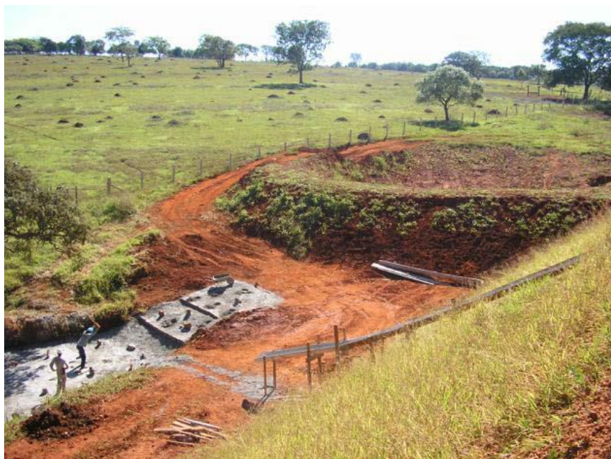
Figura 27. Aspecto geral – os empréstimos terão no máximo 100 m de extensão e eles mesmos formarão bacias de acumulação e infiltração.
