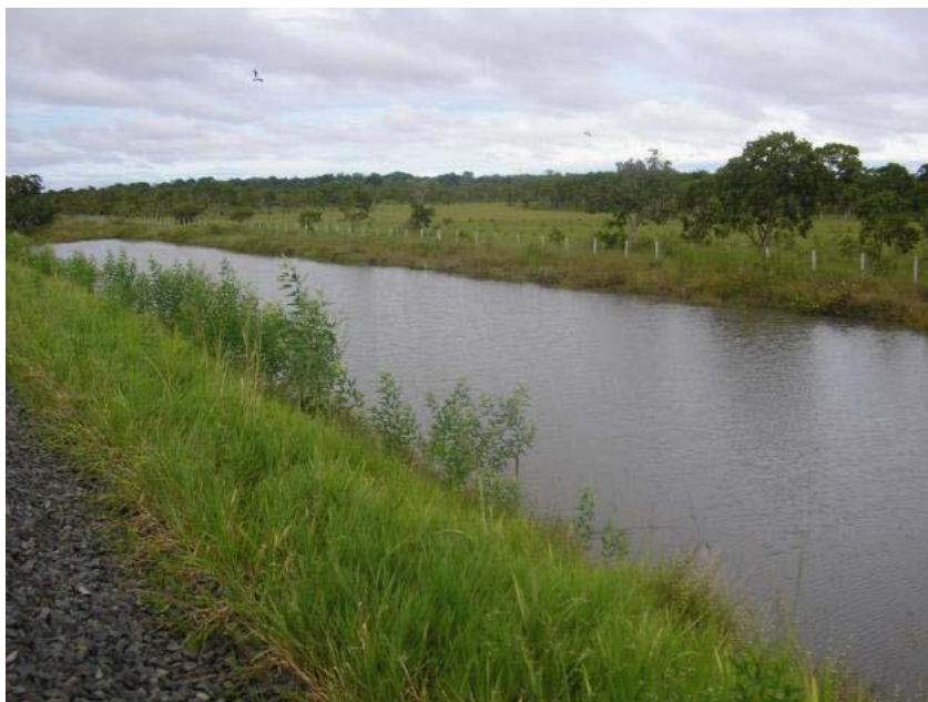
Figura 27. Aspecto geral – os empréstimos terão no máximo 100 m de extensão e eles mesmos formarão bacias de acumulação e infiltração.
