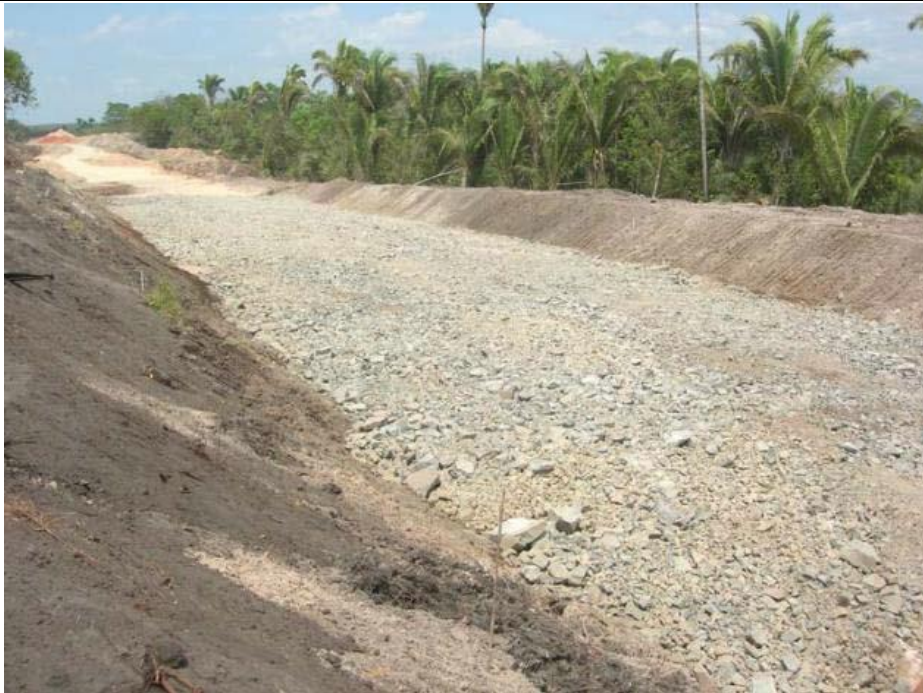
Fig. 43. Execução de colchão drenante em corte com presença de água no subleito
