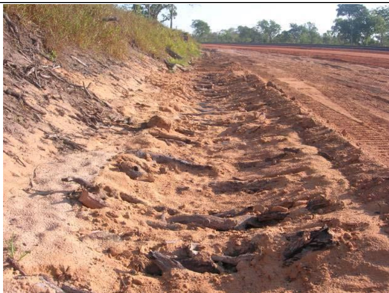
Fig. 51. Material lenhoso picotado, incorporado no solo e servindo de dissipador de energia
