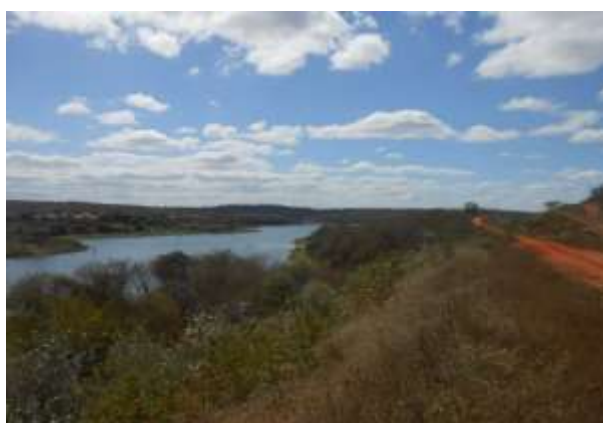
Figura 3: Vista da Barragem do Jacaré, Lote 04F, km 998 + 460.
