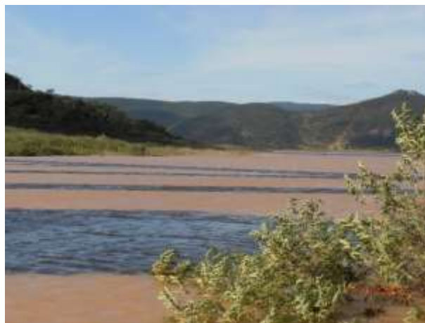
Figura 2: Barragem de Pedra, Ponte 18, jusante, km 1294+100.
