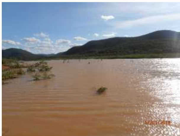
Figura 1: Barragem de Pedra, Ponte 18, montante, km 1294+100.
