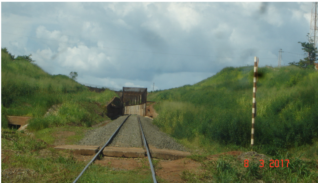
21 – Figura A.8.1.3.1 Obra finalizada no corte 01 localizado entre os km 215+400 e 216+200.
