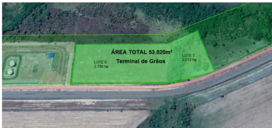
Figura 2 – Área do terminal de grãos no Pátio de Guarai/TO.
