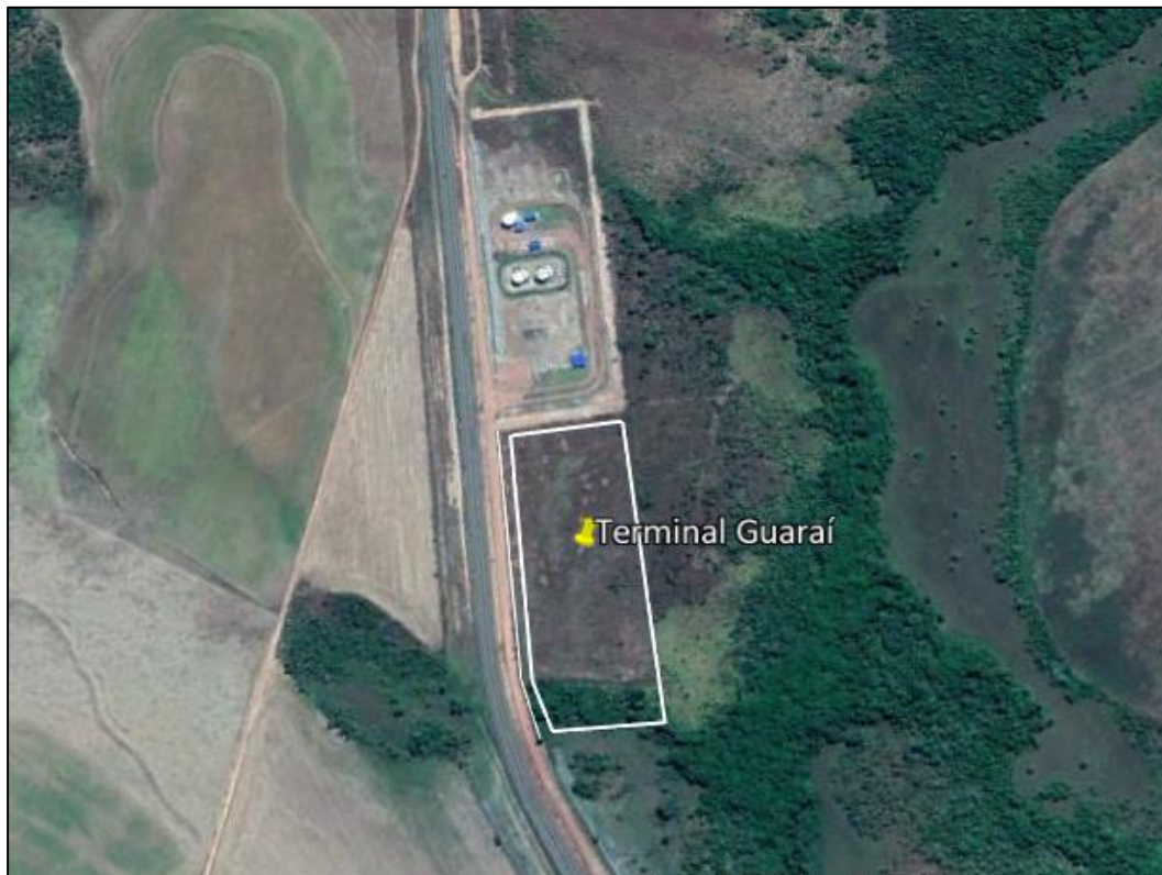
Figura 1 – Acesso à área do empreendimento no Pátio de Guarai/TO.
