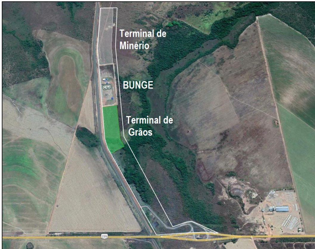
Figura 2 – Área do Pátio de Guarai/TO.
