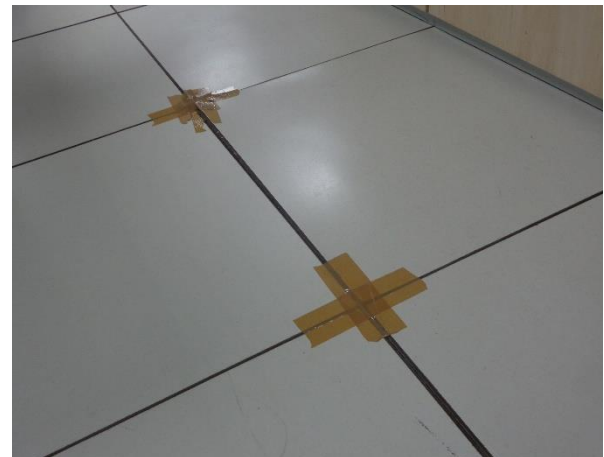
Figura 27: Lajota nivelada com fita adesiva - vista 1.
