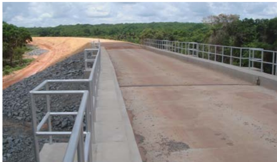
Obras de infra-estrutura no subtrecho Colinas do Tocantins-Guaráí (lote 7)
