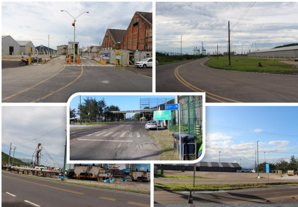
Figura 62: Estado da pavimentação e sinalização das vias intraporto. Fonte: Imagens obtidas durante visita técnica (2022). Elaboração: INFRA S.A. (2022).
