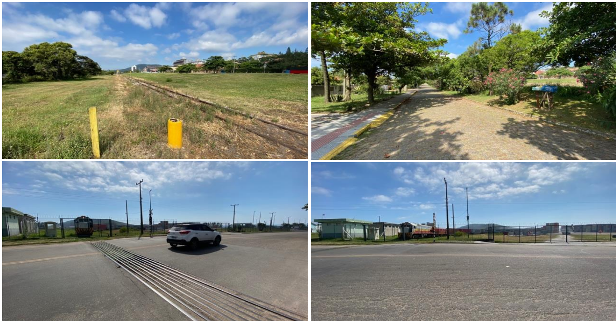
Figura 94: Vistas do acesso ferroviário ao Porto de Imbituba, junto à Av. Manoel Florentino Machado e Av. Pres. Vargas.
