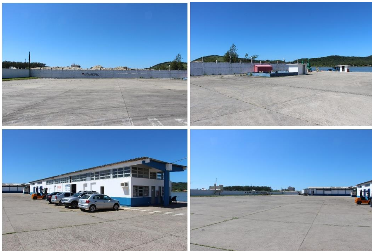
Figura 149: Pátio de manobras do Porto de Laguna. Fonte: Imagem obtida durante visita técnica da INFRA S.A (2021).
