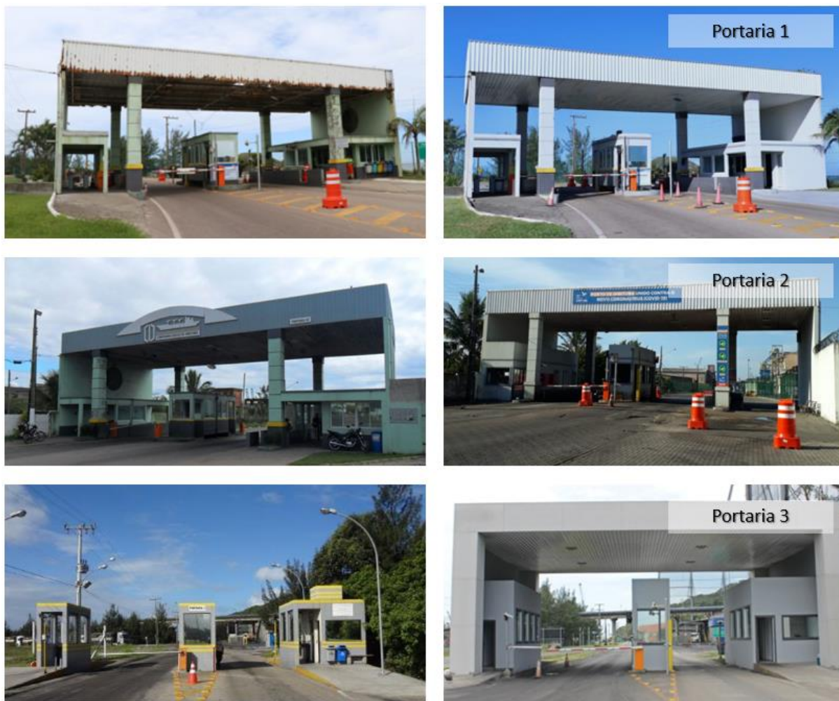
Figura 58: Portarias 1, 2 e 3 de acesso ao Porto de Imbituba (Situações: antes e depois). Fonte: Questionário on-line e SCPAR Porto de Imbituba (2021) 29 . Elaboração: INFRA S.A. (2022).
