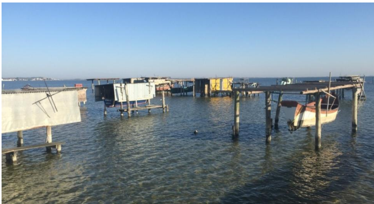
Figura 174: Sarilhos e ranchos de pesca à beira da Lagoa de Santo Antônio dos Anjos, no Portinho (Rua do Avaí).
