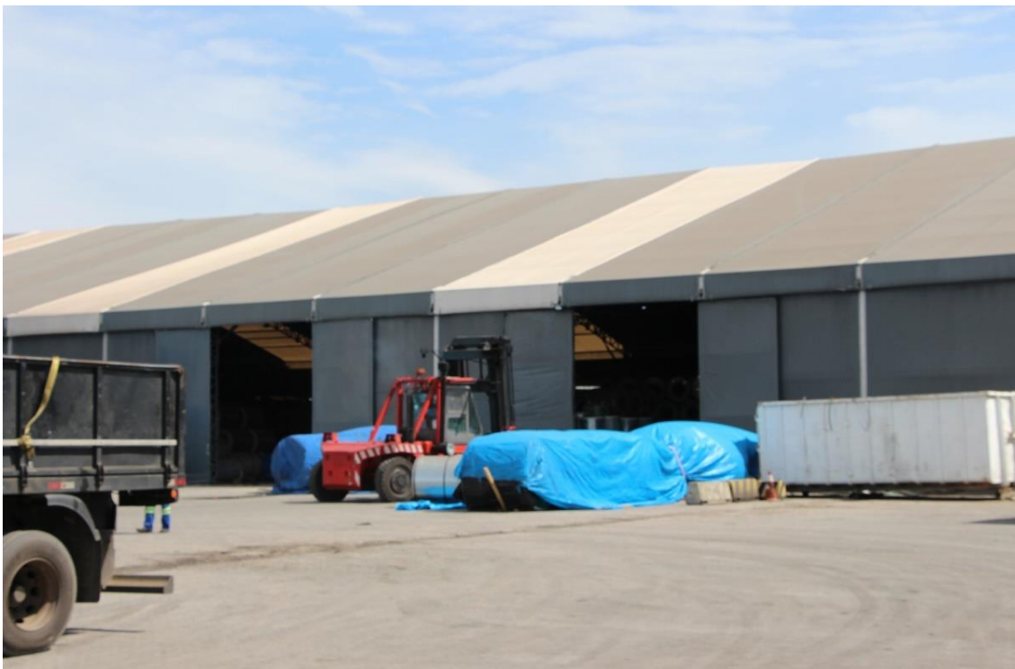
Figura 14: Armazém de lona 5 utilizado para armazenagem de carga geral. Fonte: Imagem obtida durante visita técnica da INFRA S.A. (2022).
