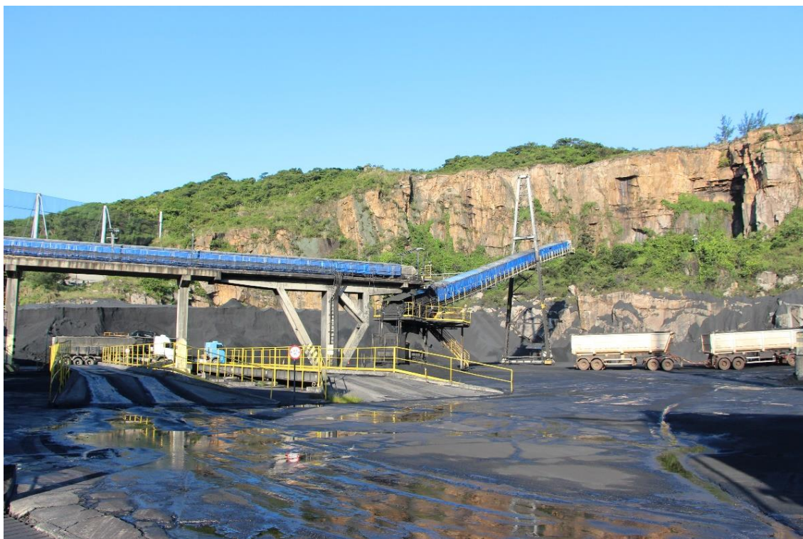
Figura 34: Correia Transportadora da CBR (trecho aéreo). Fonte: Imagem obtida durante visita técnica da INFRA S.A. (2022).
