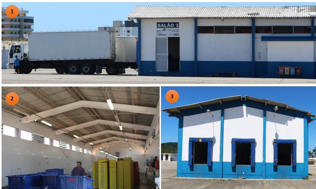
Figura 132: (1) Expedição de cargas no Salão 3; (2) Interior do Salão 3; (3) Vista posterior do Salão 4.
