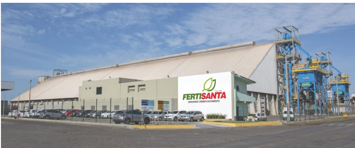
Figura 15: Armazéns 13 e 14 (Fertisanta). Fonte: Fertisanta (2022).
