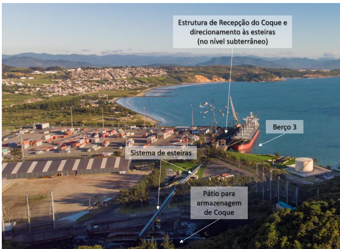
Figura 10: Berço 3 e sistema de recepção e transporte do coque ao Pátio.
