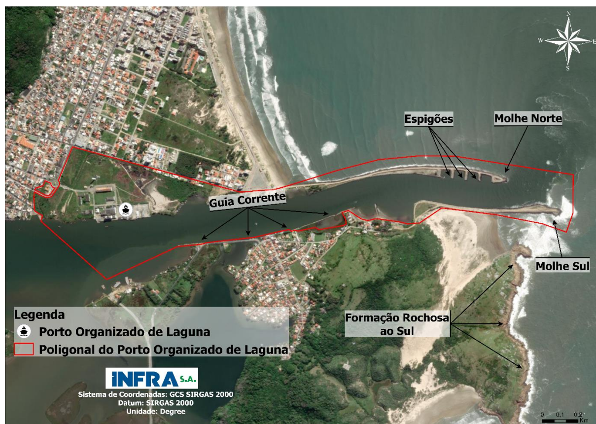
Figura 126: Obras de Abrigo do Porto de Laguna.
