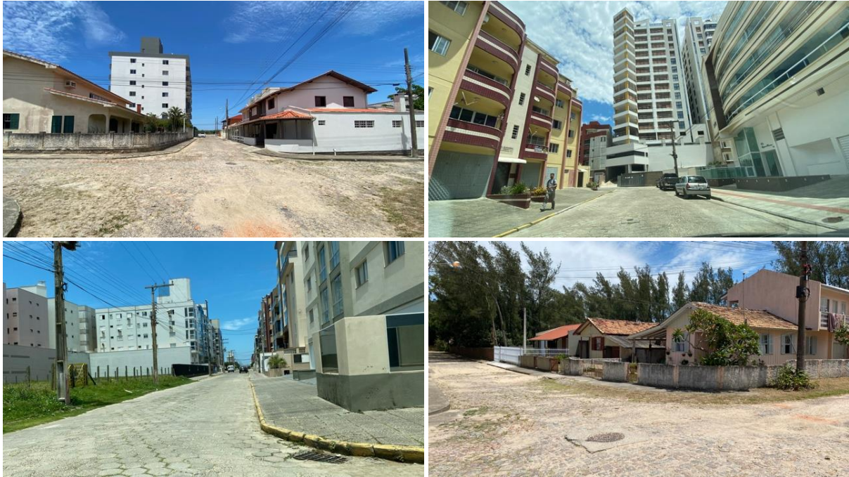
Figura 165: Vistas do bairro Mar Grosso, junto ao Porto Organizado de Laguna.
