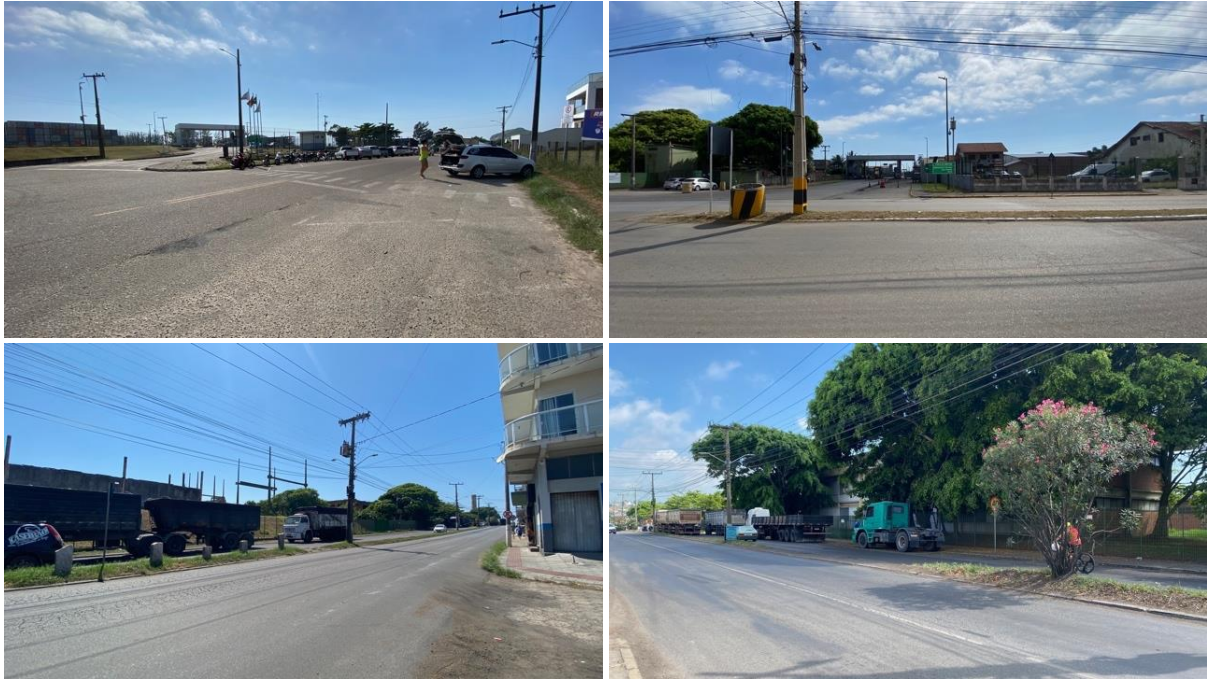
Figura 92: Portarias de acesso de veículos ao Porto de Imbituba, com ocorrência de caminhões estacionados à Av. Manoel Florentino Machado.
