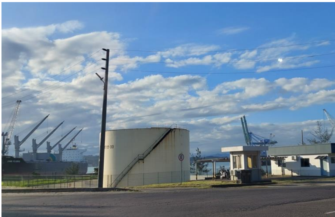
Figura 20: Tanque 1 (utilizado no armazenamento de soda cáustica)
