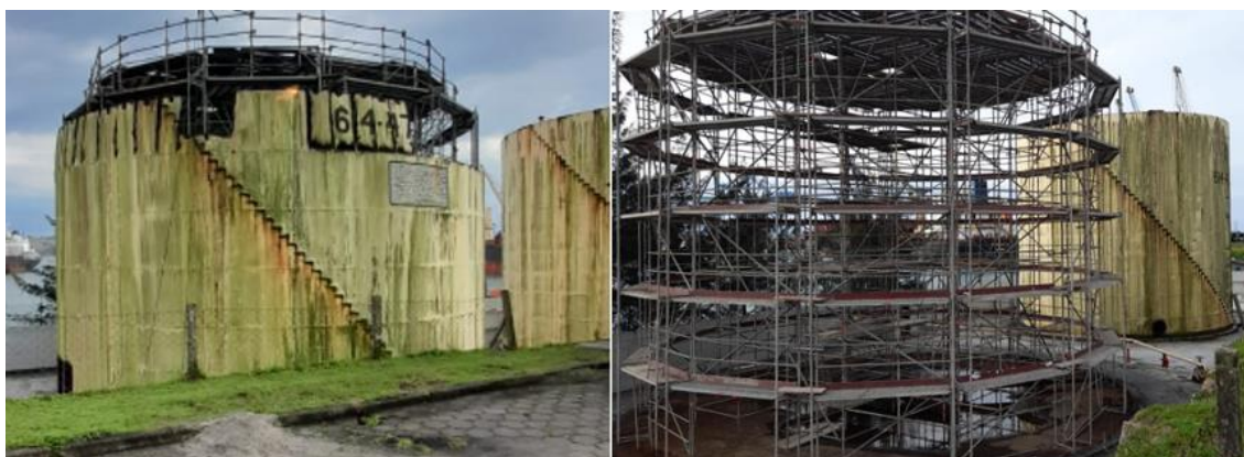
Figura 19: Fases distintas de desmontagem do Tanque 2 (à esquerda) e fase inicial de desmontagem das escadas do Tanque 3 (à direita).
