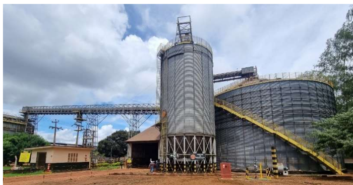
Foto 10: Vista silo vertical e horizontal
