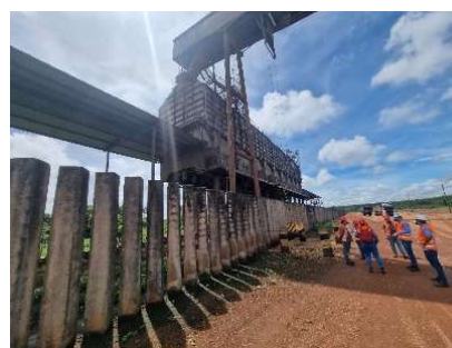
Foto 04: Vista externa da tolha
