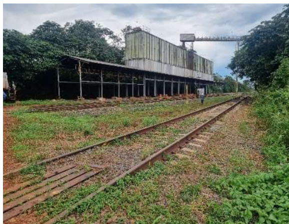
Foto 16: Vista da Tulha ADM e Esteira de carregamento da Tulha
